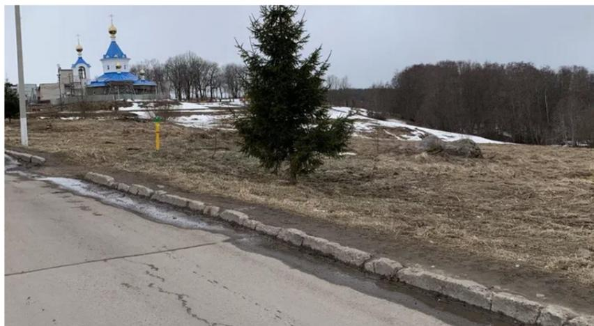
Покрытия в аварийном состоянии деформированные. Необходима замена верхних слоев финишных покрытий, возможно полная замена пирога покрытий.
